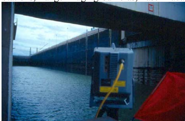
Illustration 1 : chambre d'écluse 2 de la centrale électrique du Danube Gabčíkovo (SK)
